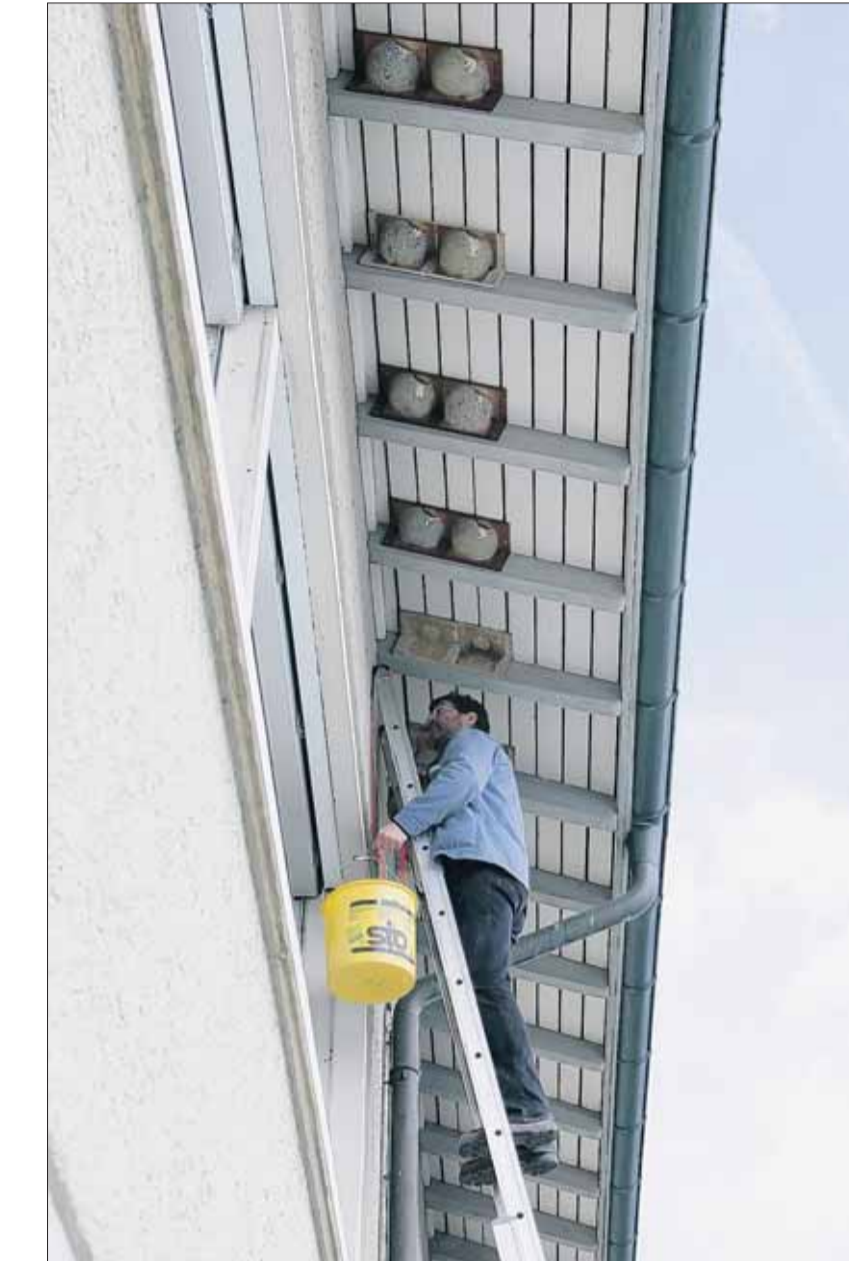
Wegen der Bauarbeiten werden die Nester auf der Ostseite entfernt. (Re)
