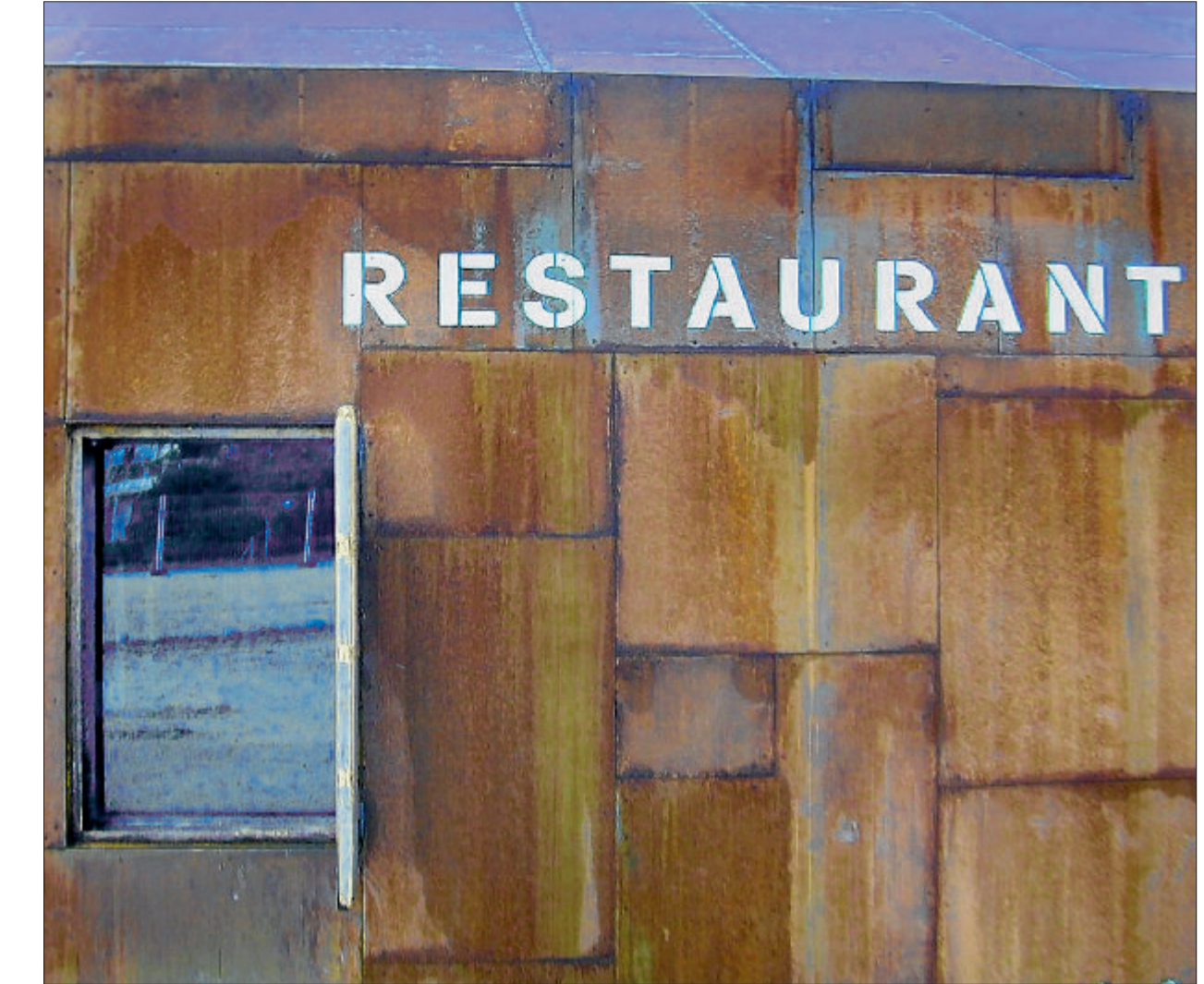
Streit um «La Boîte» geht weiter: Der Rheinaubund rekuriert gegen die Baubewilligung von Stadt und Kanton. (Archiv)
