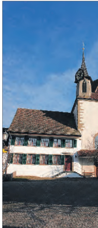
Umbau im Gemeindehaus: Dafür will Greifensee 1,7 Millionen ausgeben. (sjm)
