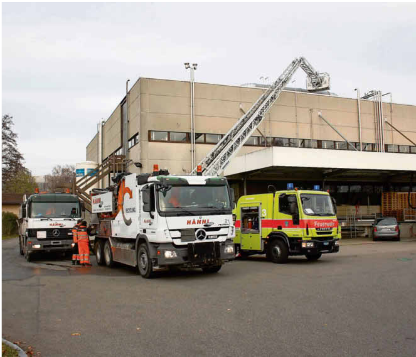
In diesem Gebäude brach nach einer Verpuffung ein Brand aus. Jetzt wird das Löschwasser abgesaugt. Bild: Eduard Gautschi
