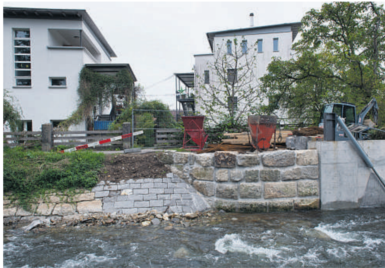
Die Mauer aus Quadern am Aabach in Uster ist neu aufzuschichten, damit sie dem Anspruch der Denkmalpflege genügt.
