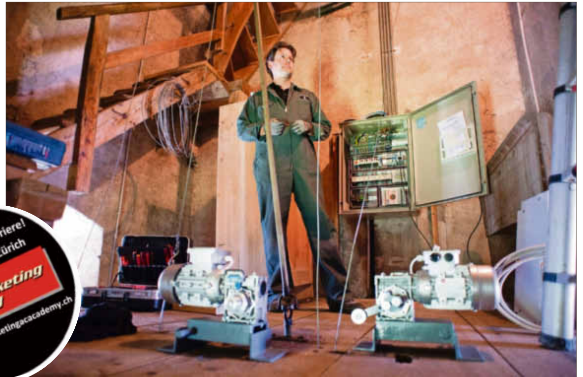
Branco Strbac baut die beiden Motoren ein, die den Viertelstundenschlag unterbrechen. Bild: Carole Fleischmann
