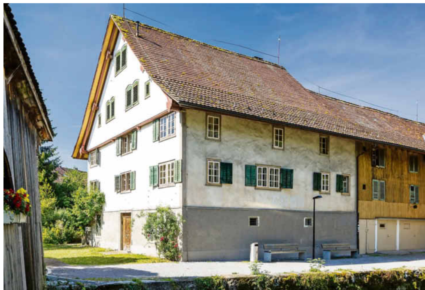
Die ehemalige Färberei: 1672 wurde die Untere Farb das erste Mal urkundlich erwähnt. Geht es nach der Stadt, beinhaltet das unter Schutz stehende Gebäude in Zukunft das Stadtarchiv, das heute auf verschiedene Standorte verteilt ist.
