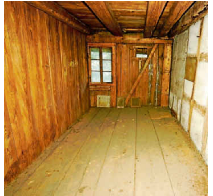
Die Stadt plant, eine zweite innere Hülle in die Scheune zu bauen.
