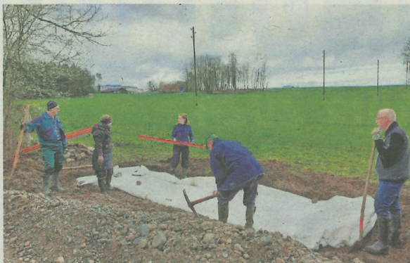
Die Gruben wurden mit Flies, Plane und Wandkies ausgekleidet – nun können Frösche, Unken und viele weitere Tiere die Biotope beleben. Fotos: Daniel Hardegger
